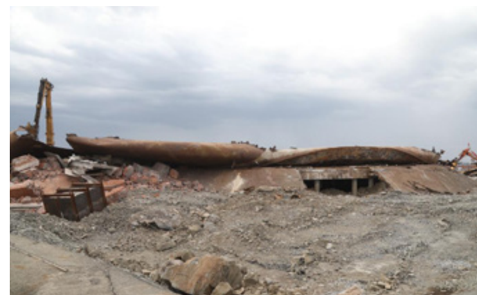
Рис. Демонтаж аварийного резервуара №5
