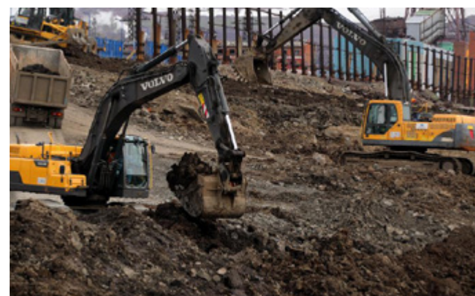
Рис. Работы по сбору и вывозу загрязненного грунта на территории разлива
