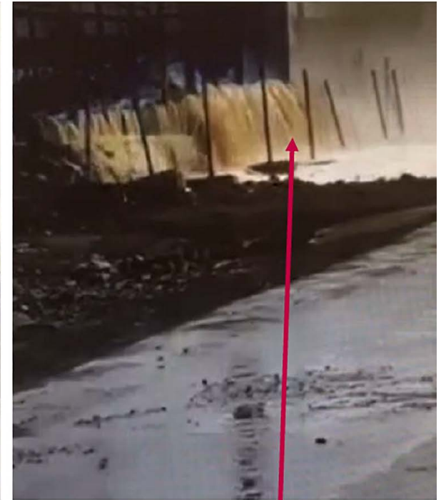
Дизельное топливо вытекает за стенки обвалования наружу
