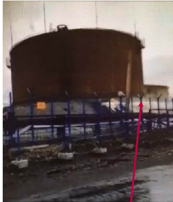
Динамическая сила выброса дизельного топлива привела к его переливу за пределы стенок обвалования
